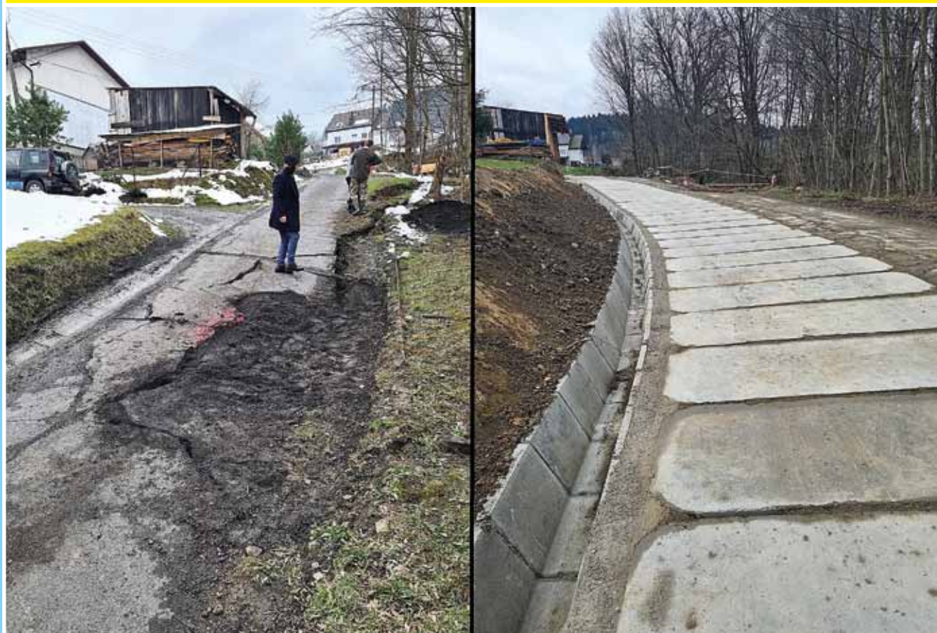
Przed rozpoczęciem prac
